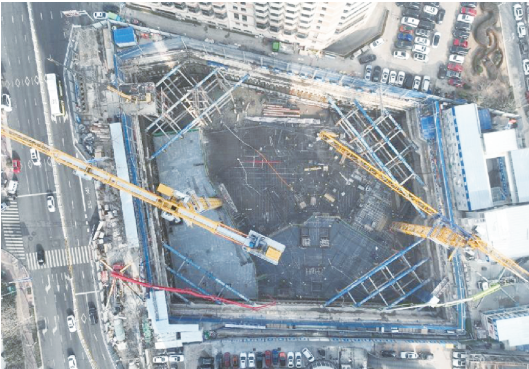
航运贸易金融总部大厦施工现场。
